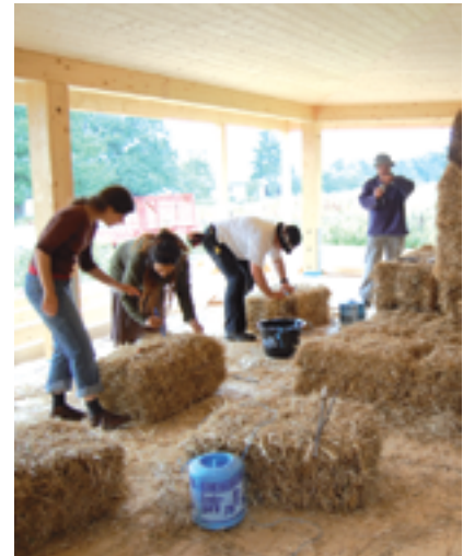
Vorbereiten der Strohballen
