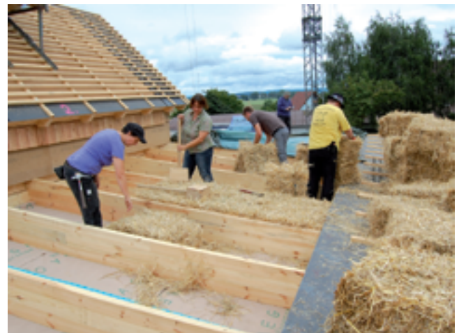
Strohballen-Dachdämmung
