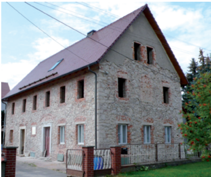
Noch sind die Kastenfenster nicht wieder eingebaut, das Haus noch unverputzt
