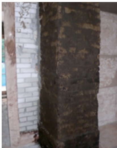
Schornsteinsanierung: Kuhdung, Lehmputz, 2-lagig
