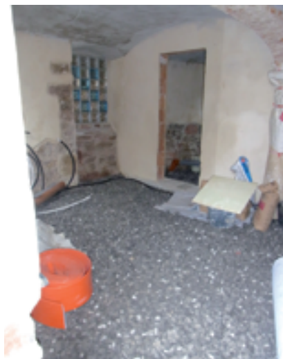
Schaumglasschotter als kapillarbrechende Wärmedämm- und Tragschicht für den Stamflehm
