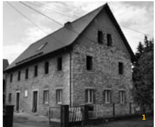
1 Gebäudeaußenansicht nach dem Abputzen. Der Dachstuhl wurde vor dem Beginn der Umbaumaßnahme im Rahmen einer ca. 5 Jahre zurückliegenden Sicherungsmaßnahme saniert und das Dach damit neu gedeckt. Andere Kriterien lagen den Entscheidungen zugrunde. (Foto: Brück)
